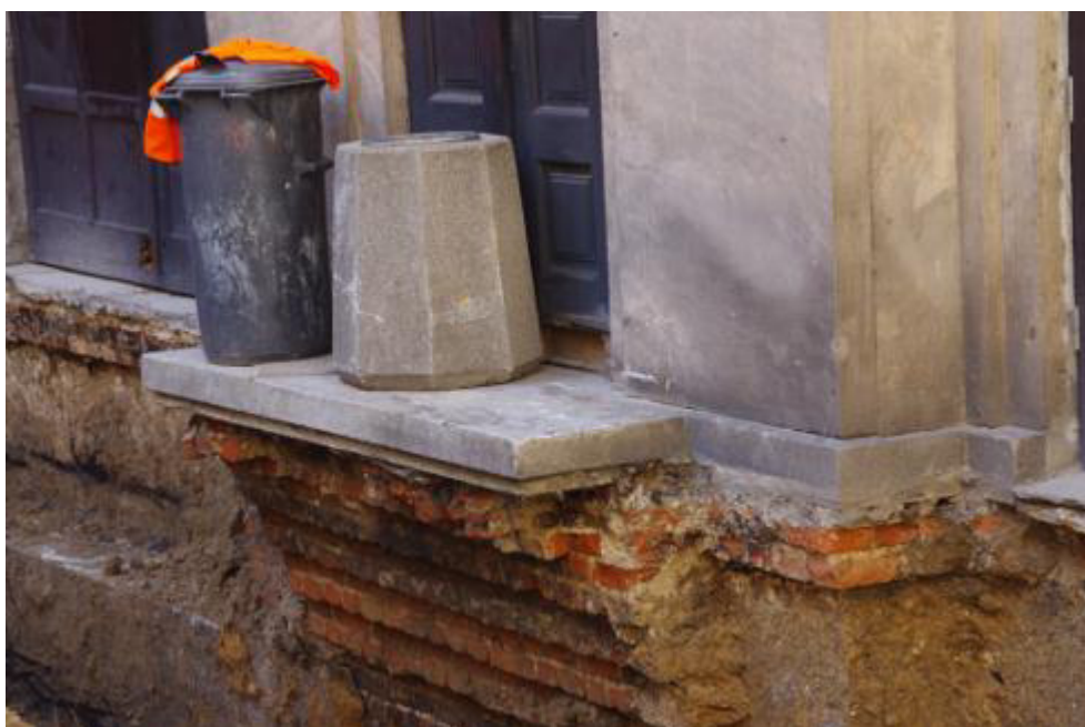
36. Działanie nr 3 – północno – zachodni Fragment elewacji zachodniej pod okopaniem fundamentów
