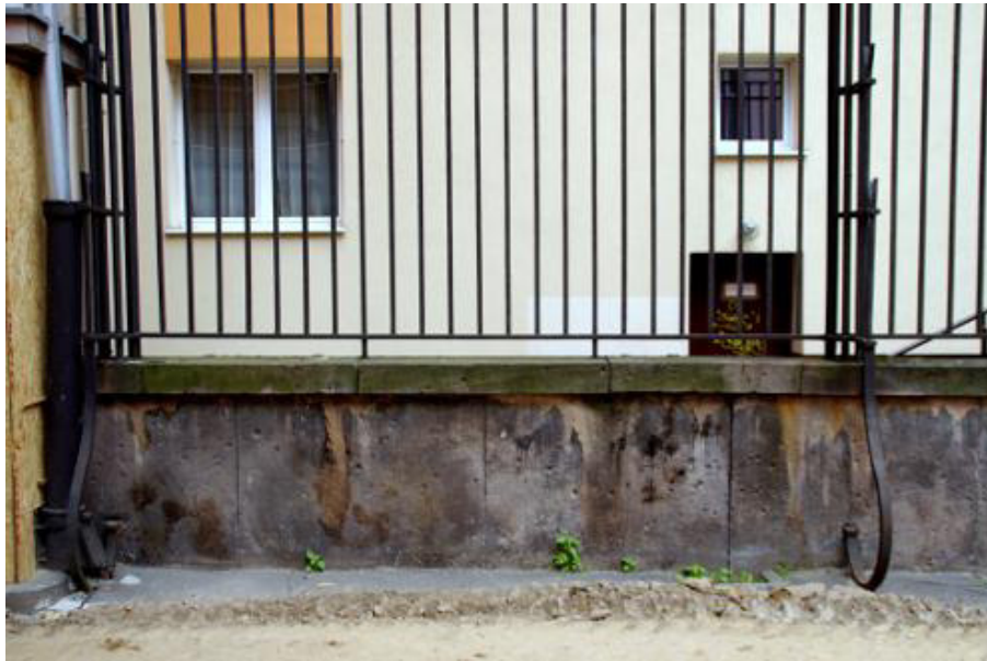
21. Cokół ogrodzenia dziedzińca nr 2 Wyraźnie widać seryjne postrzały z ciężkich karabinów maszynowych
