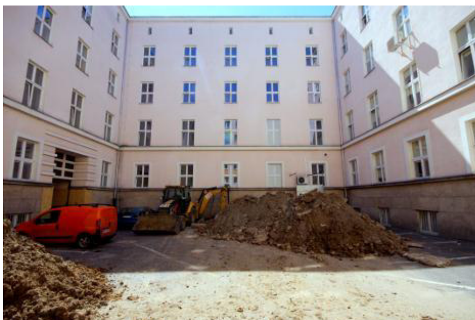
12. Działanie nr 2 – północno – wschodni Widok w kierunku elewacji południowej gmachu
