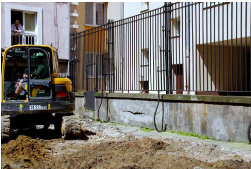
33. Działziniec nr 3 – północno – zachodni Fragment ogrodzenia od strony północnej
