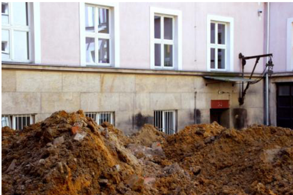
35. Działanie nr 3 – północno - zachodni Widok fragmentu elewacji południowej
