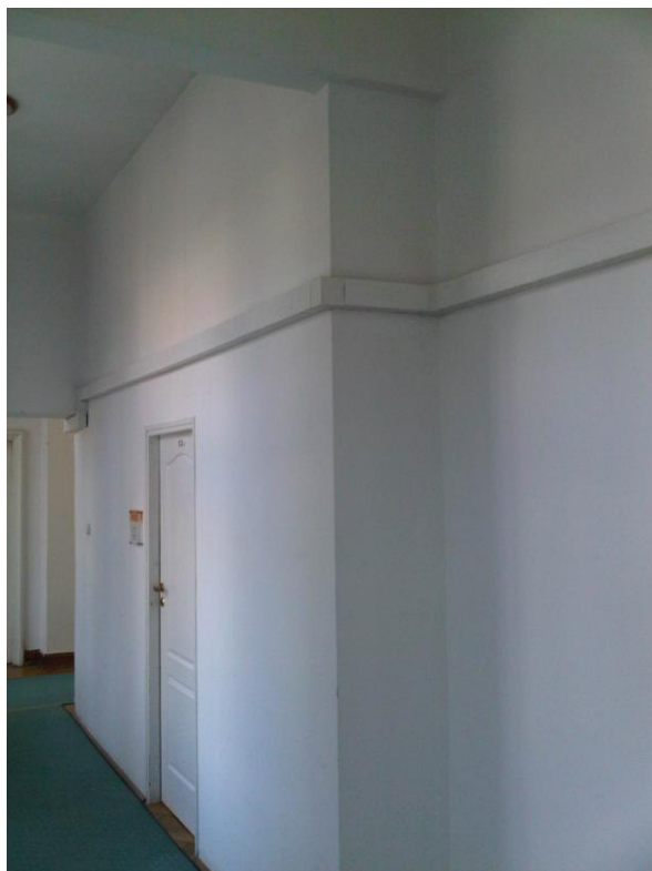
Fot. 21 widok ściany działowej przewidzianej do rozbiórki i odtworzenia zgodnie z pierwotnym stanem (korytarz I piętra)
