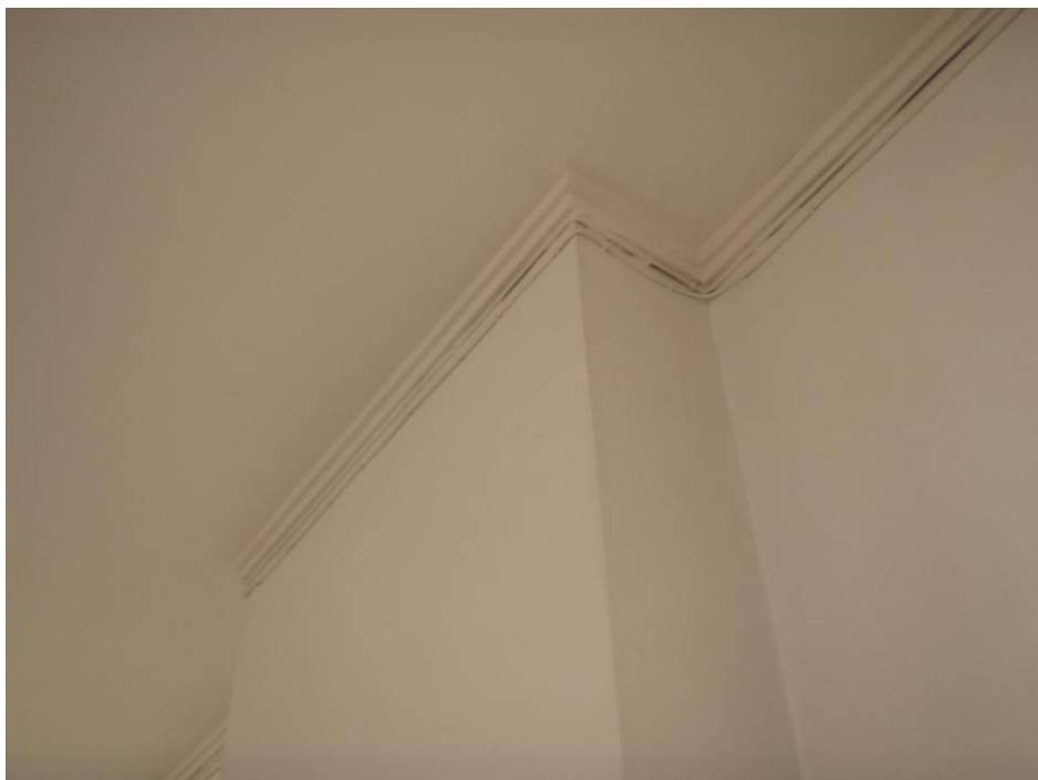
Fot. 9 widok sztukaterii do renowacji oraz instalacji do wkucia w ścianę
