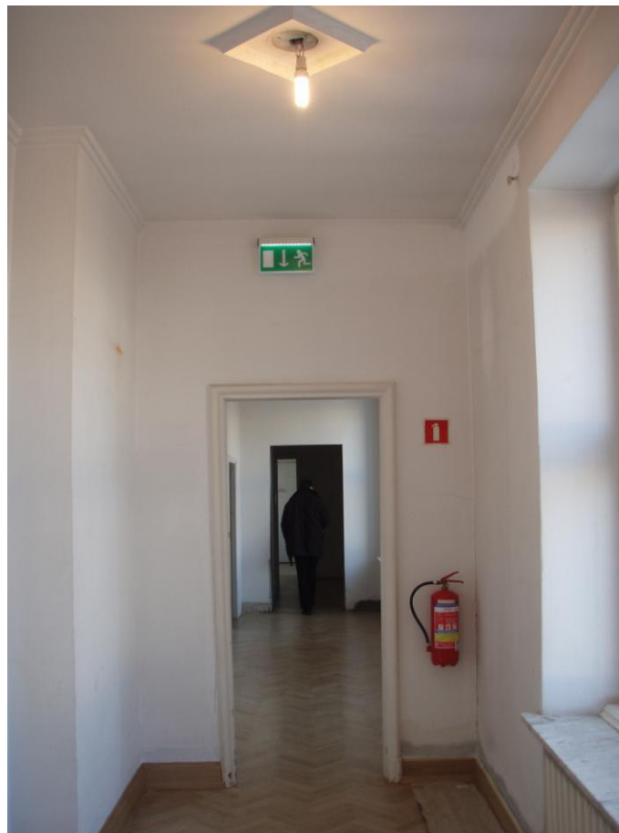
Fot. 20 widok ściany działowej przewidzianej do rozbiórki (korytarz III piętra)
