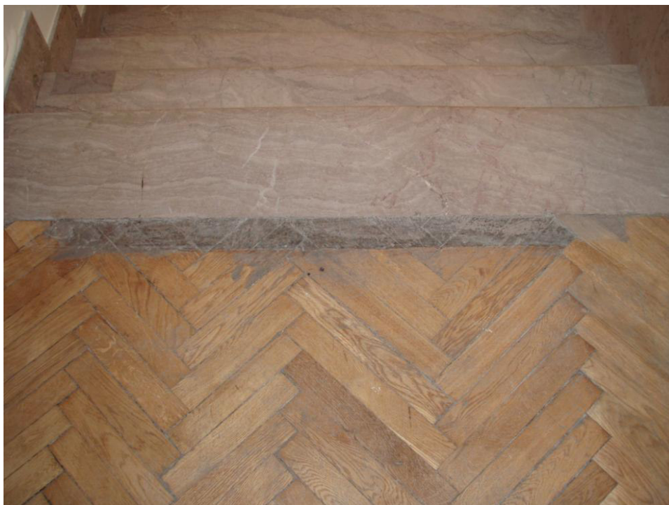
Fot. 2 widok połączenia posadzki kamiennej z drewnianą
