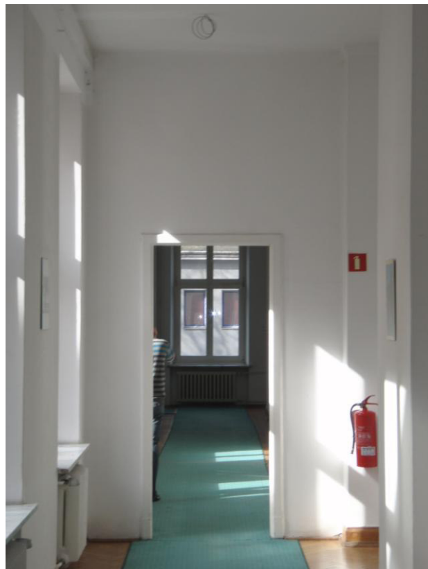
Fot. 18 widok ściany działowej przewidzianej do rozbiórki (korytarz I piętra)
