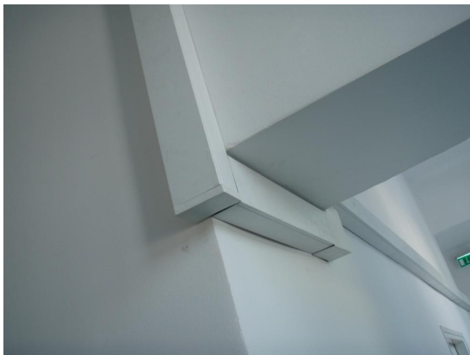
Fot. 12 widok instalacji teletechnicznych do wkucia w ścianę
