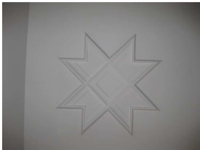
Widok rozety w pomieszczeniu nr 208
