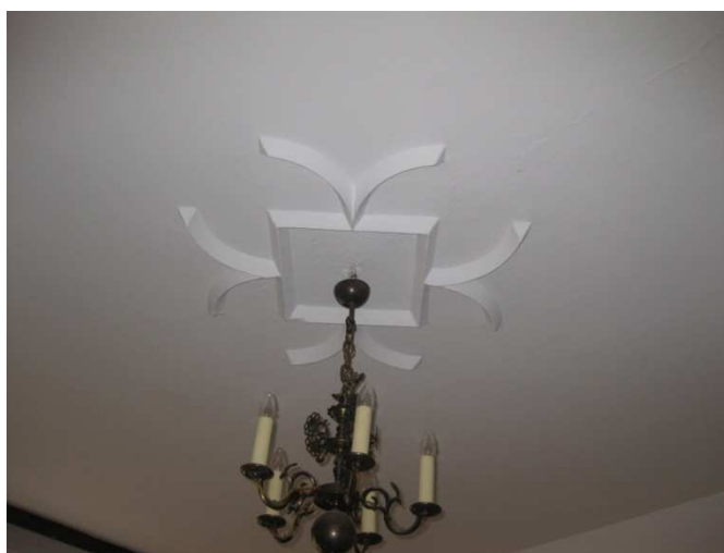
Widok rozety w pomieszczeniu nr 209
