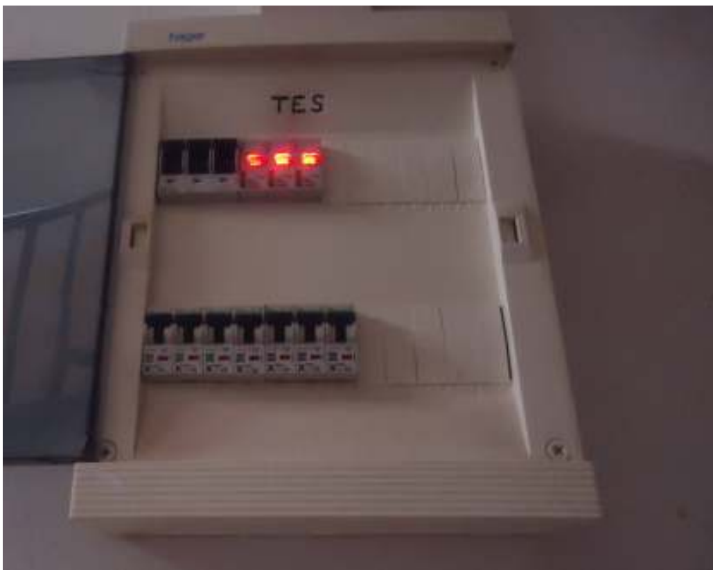
Pom. „-1KS1” Rozdzielnica TES – do demontażu, urządzenia przełożyć do RF1, obwody przełączyć do RF1.
