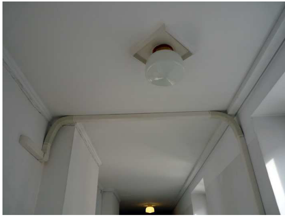
Widok instalacji klimatyzacji przewidzianej do wkucia pod nowy parkiet
