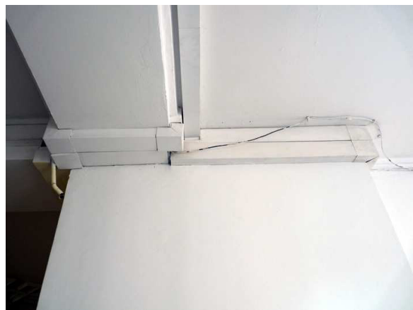
Widok instalacji przewidzianej do wkucia w ścianę lub wprowadzenia w koryta PCV
