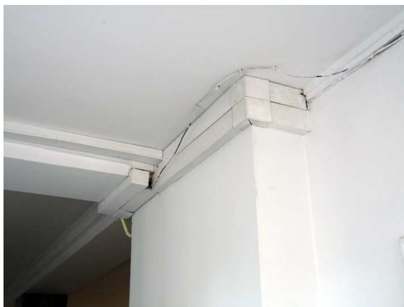
Widok instalacji przewidzianej do wkucia w ścianę lub wprowadzenia w koryta PCV
