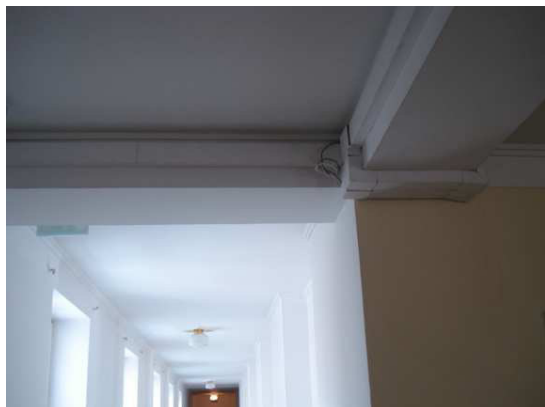
Rys. f-05 Listwa instalacyjna do wkucia lub zabudowy poprzez zlicowanie
