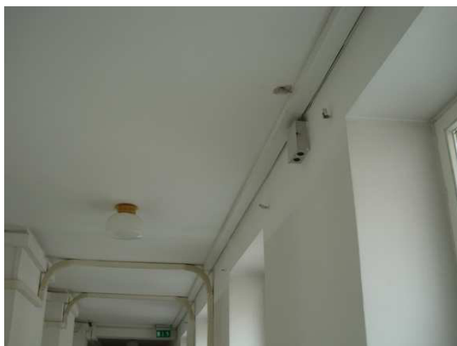
Rys. f-08 Listwa instalacyjna do wkucia;
