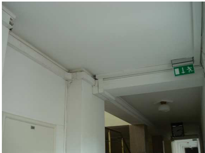
Rys. f-09 Listwa instalacyjna do wkucia lub zabudowy poprzez zlicowanie;
