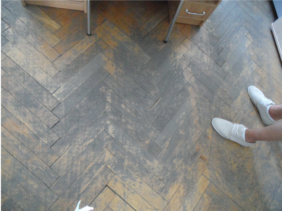
Zdjęcie nr 2. Pomieszczenie nr 319, szczeliny między deskami parkietu i wytarcia desek.
