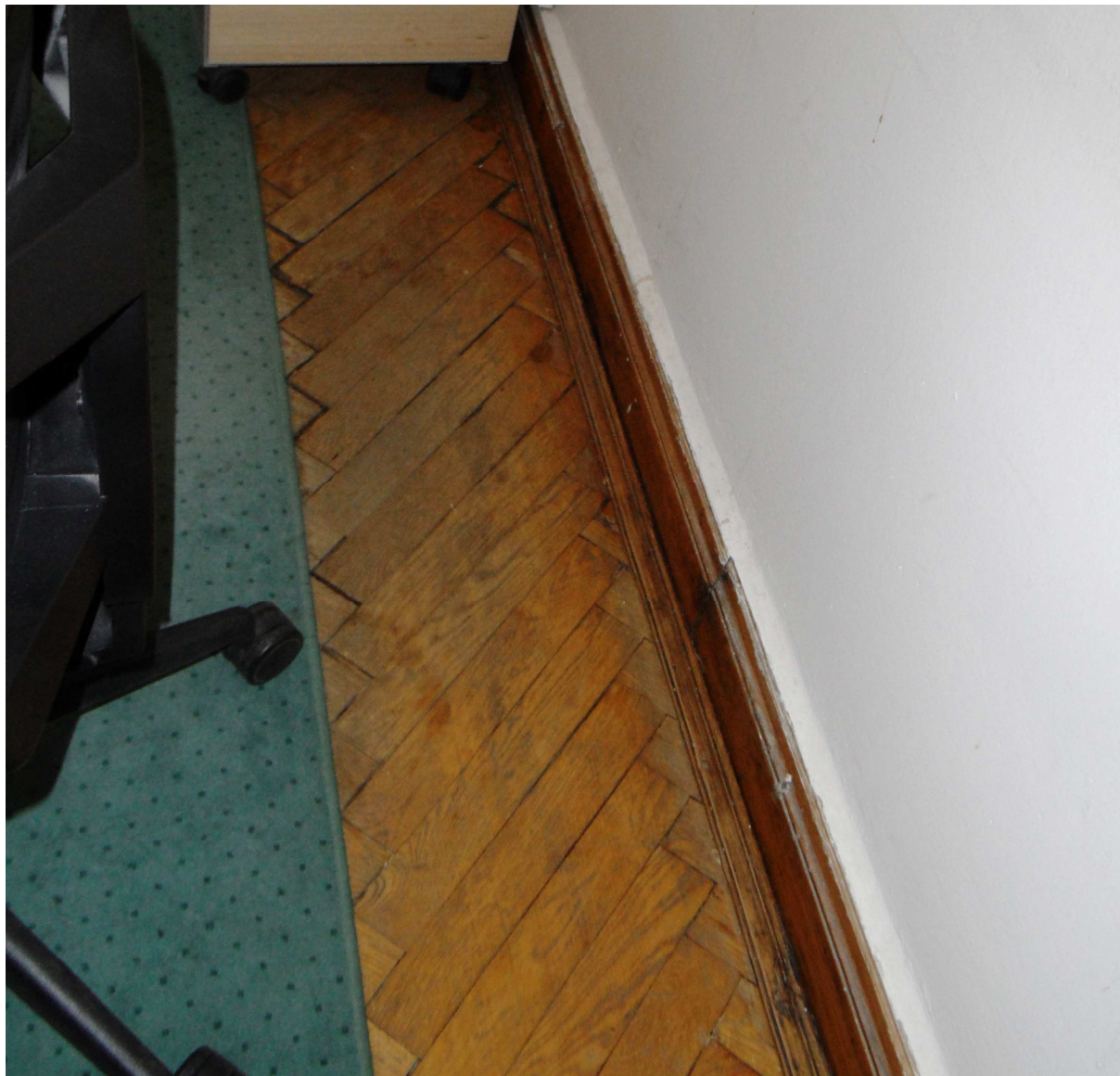
Zdjęcie nr 1. Pomieszczenie nr 327, szczeliny między deskami parkietu i wytarcia desek.
