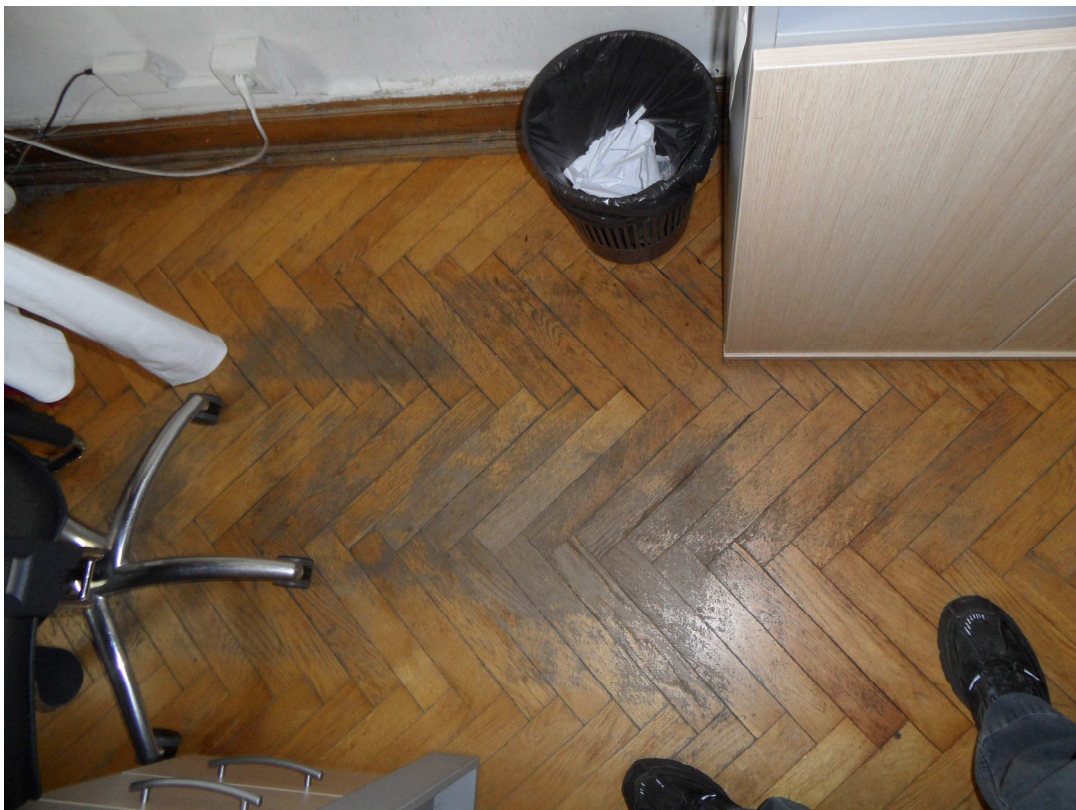
Zdjęcie nr 3. Pomieszczenie nr 335, szczeliny między deskami parkietu i wytarcia desek.
