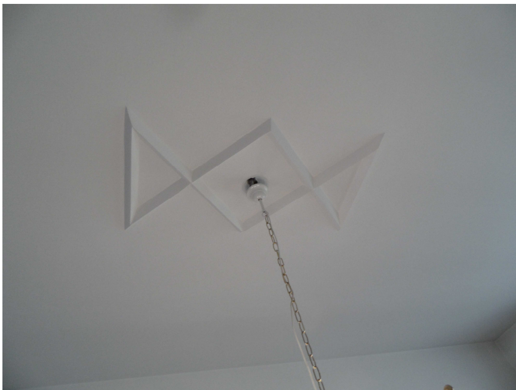
Zdjęcie nr 12. Pomieszczenie nr 356, rozeta sufitowa zachowana w dobrym stanie, kompletna.
