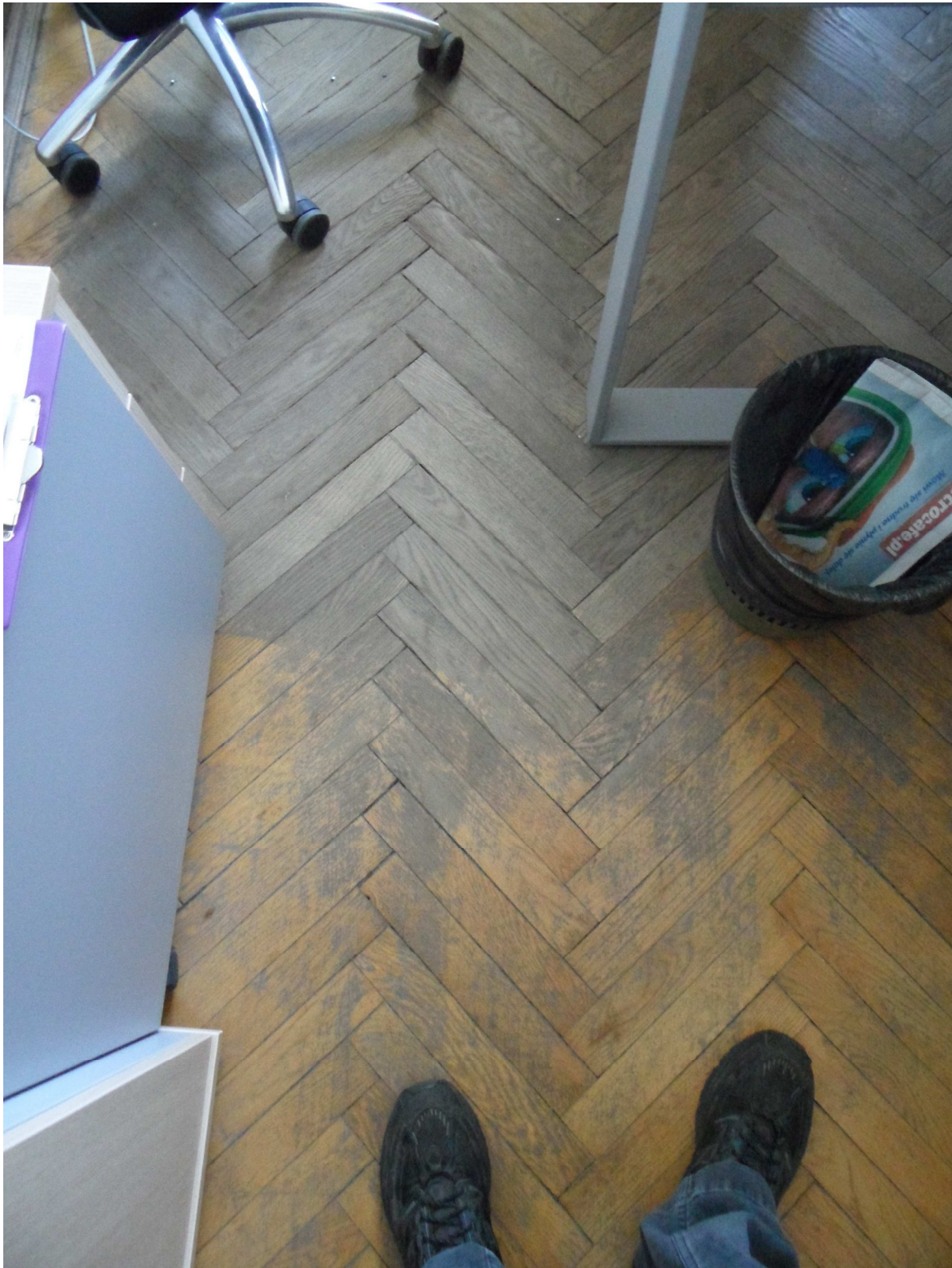
Zdjęcie nr 4. Pomieszczenie nr 323, szczeliny między deskami parkietu i wytarcia desek.
