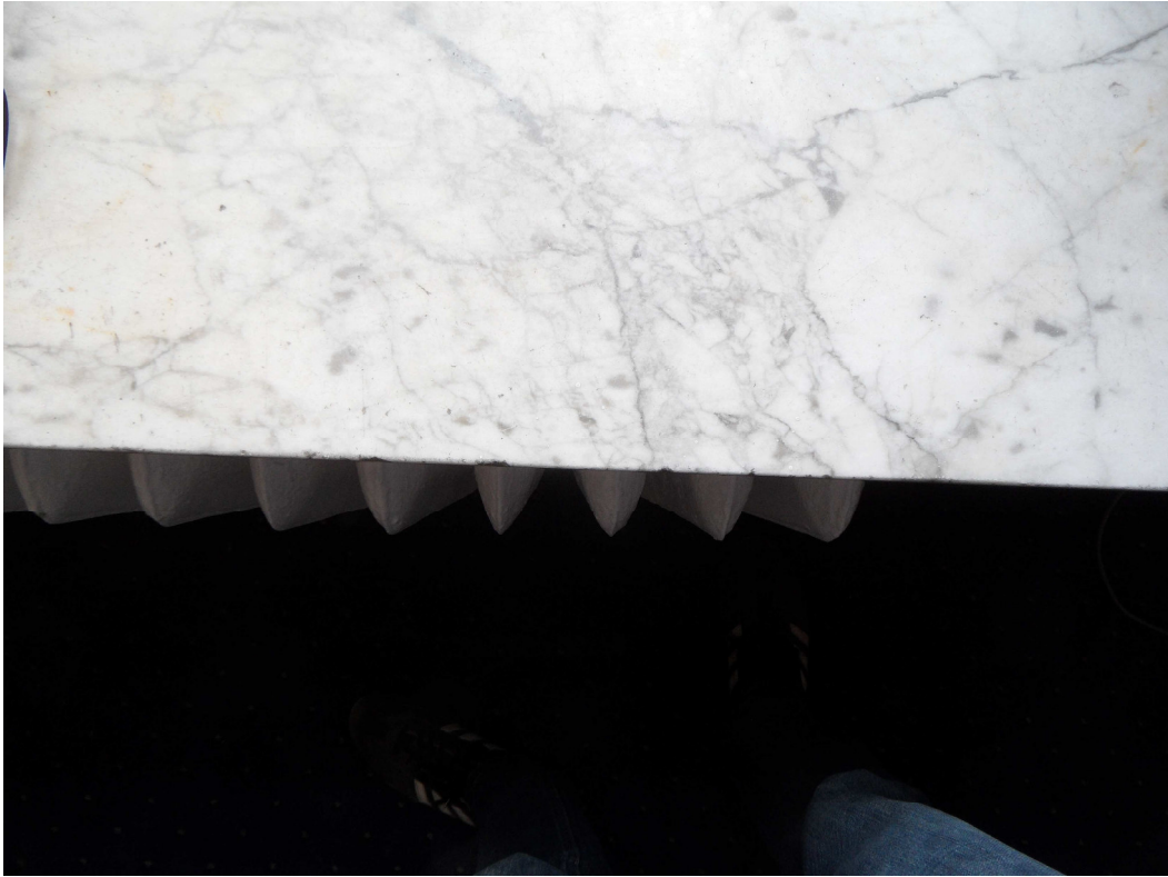
Zdjęcie nr 14. Pomieszczenie nr 369, ubytki oryginalnego parapetu marmurowego.
