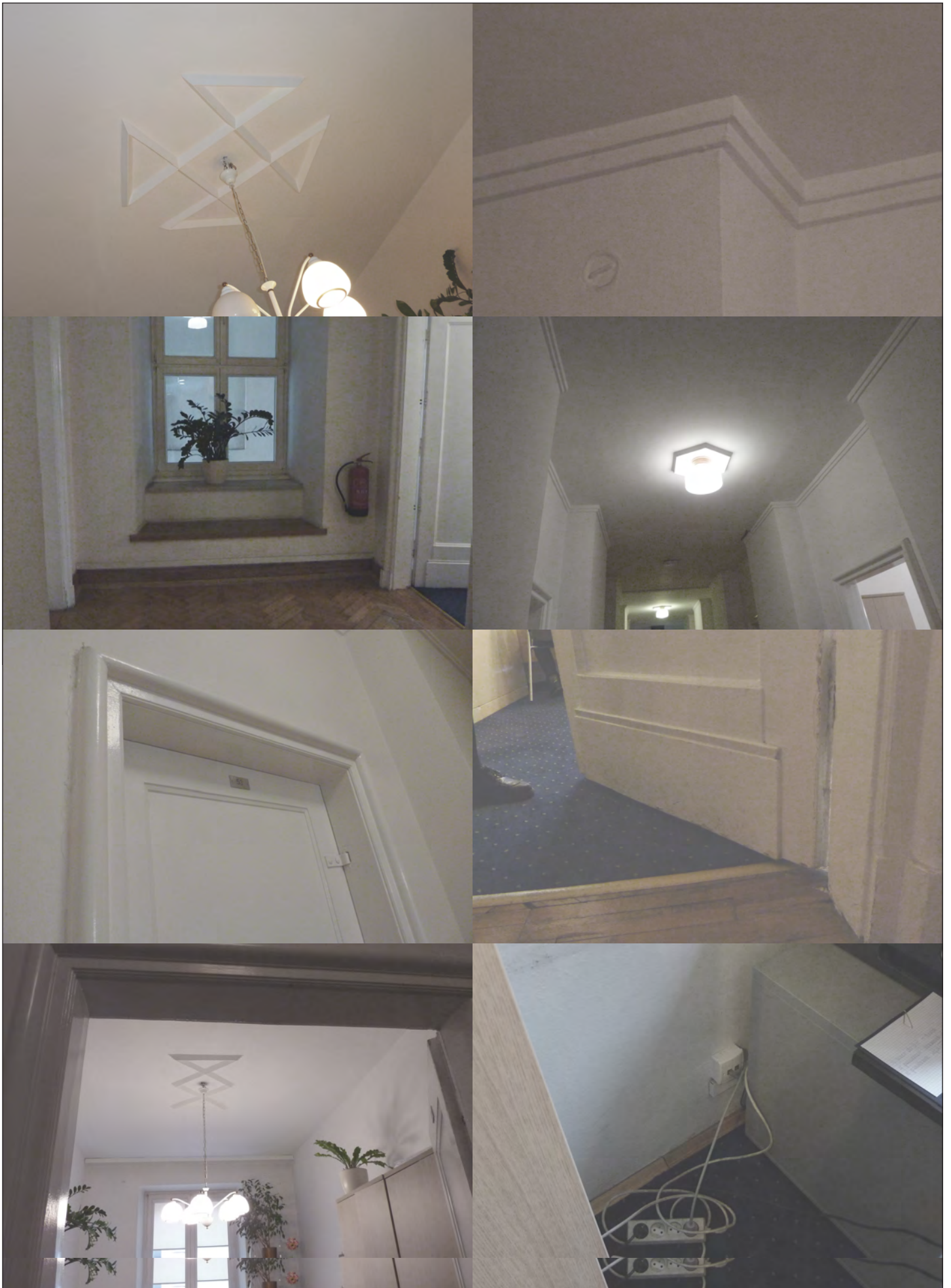
Dokumentacja fotograficzna - stan istniejący.
