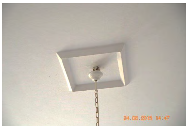
Fot 9 Sztukaterie -typ „02” – dekoracja prawdopodobnie niepełna, dla której można podejrzewać ubytki w strefie analogicznie jak w sztukaterii w typie A, B, C, D, E.
