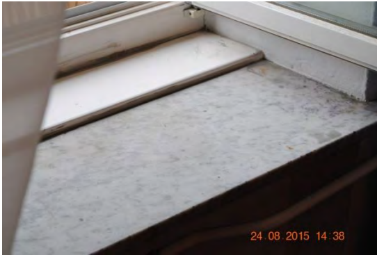
Fot. 1 MEN. Parapet, widok ogólny.
