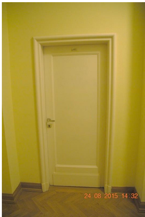
Fot. 10 MEN. Drzwi - widok ogólny.
