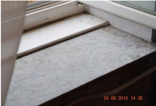
Fot. 1 MEN. Parapet, widok ogólny.
