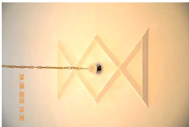
Fot. 5 MEN. Sztukaterie -typ C – zakładana pełna forma dekoracji lub dekoracja posiada ubytki względem bryły w typie B
