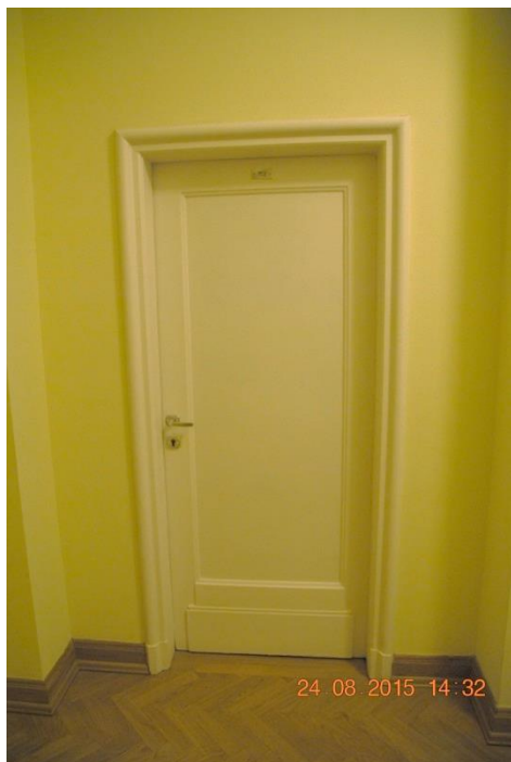
Fot. 10 MEN. Drzwi - widok ogólny.
